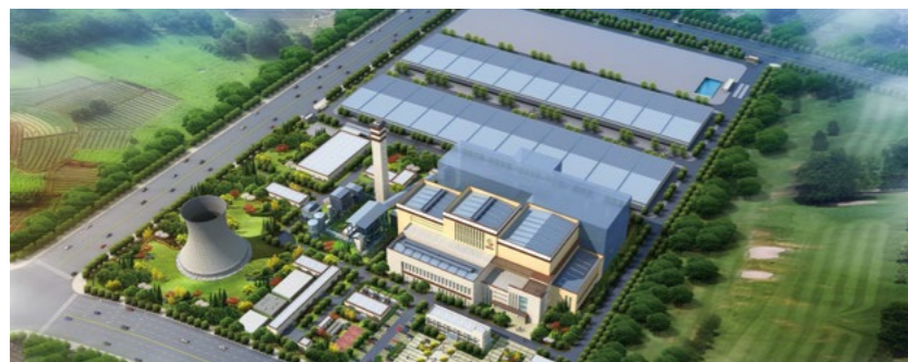
国内第一座城乡一体化热电联产 EPC 模式项目
