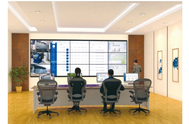
生活垃圾智能收集系统试点中控室
